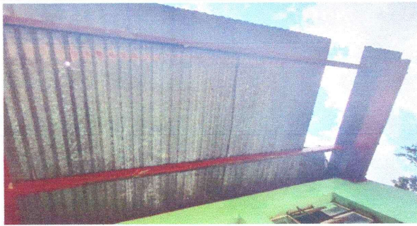
Foto1: Desmontaje e instalación de cubierta de lamina calibre 26.
