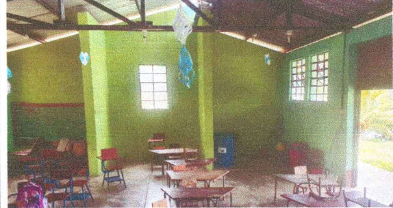
Foto 4: Aplicación a dos manos de pintura en interior del establecimiento.
